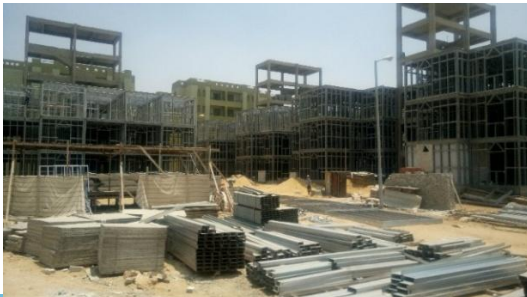
شكل رقم (7) تشكيل وتجميع البانوهات بموقع المشروع
