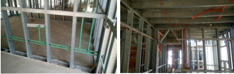
شكل رقم (9) تنفيذ أعمال التمديدات الصحية والكهربائية
