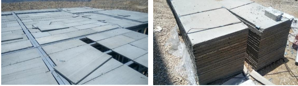
استخدام ألواح الفيروسيمينت لتغطية الأسطح
